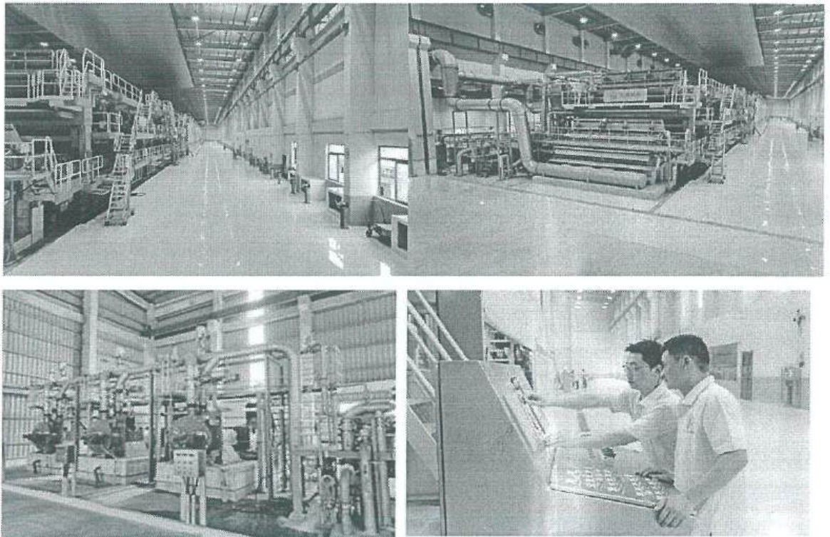
Hình ảnh hệ thống điện tự động
